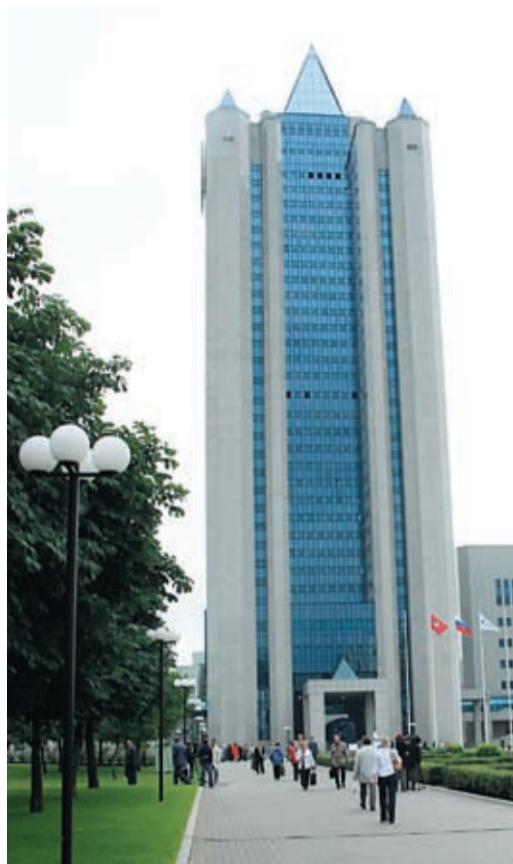
Центральный офис Газпрома в Москве
